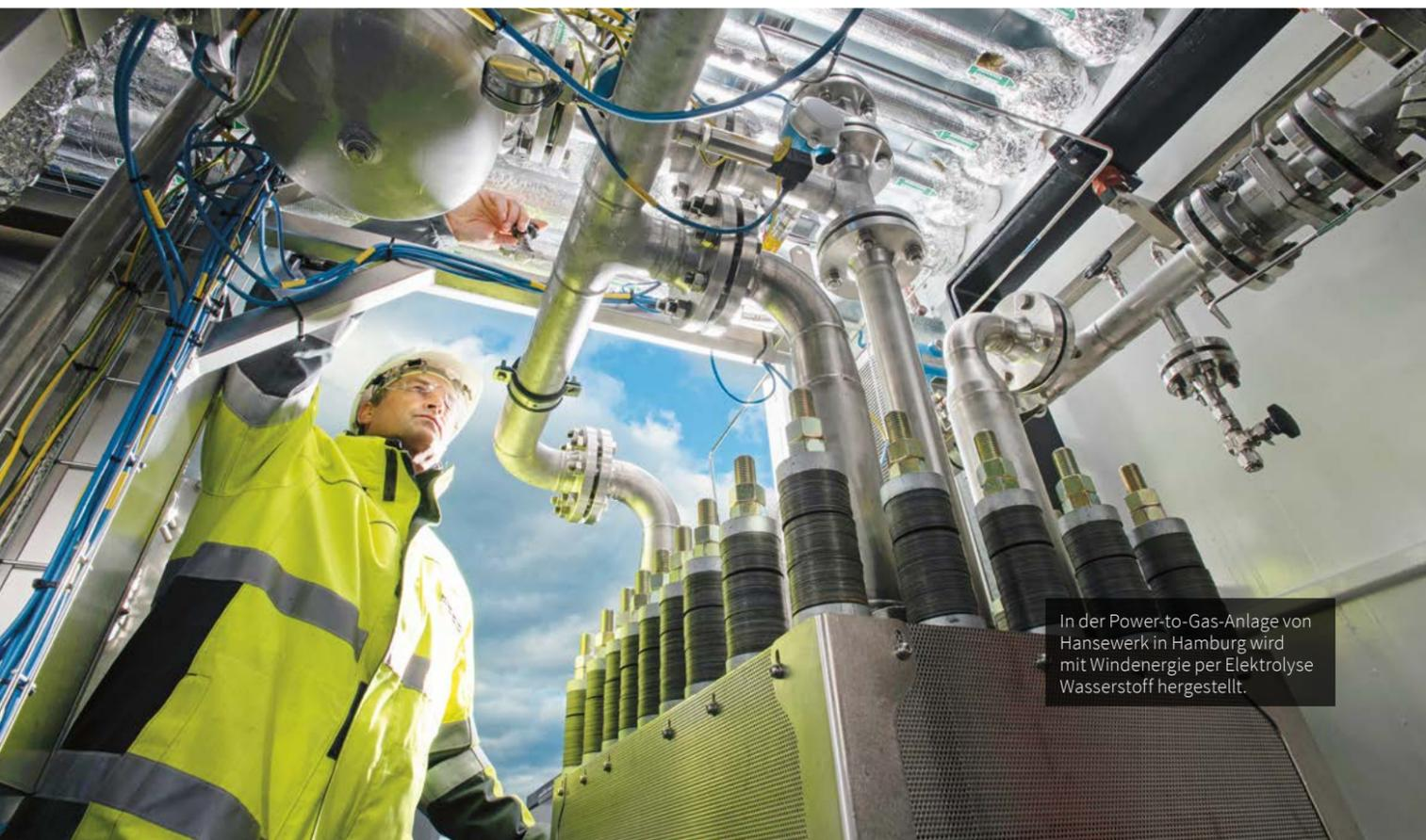
In der Power-to-Gas-Anlage von Hansewerk in Hamburg wird mit Windenergie per Elektrolyse Wasserstoff hergestellt.
